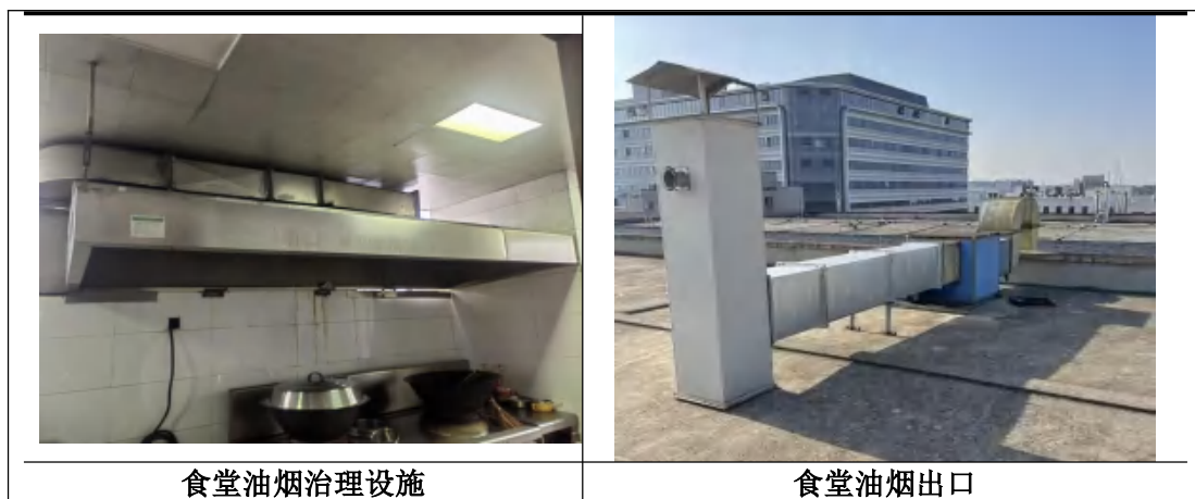
图 3-4 废气处理设施及排放口照片
