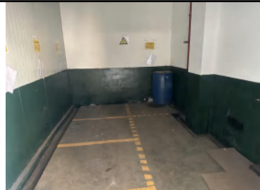
危废仓库内部照片
